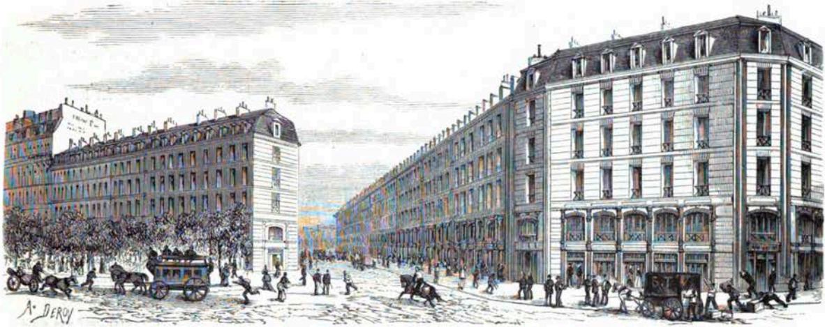
LES NOUVEAUX IMMEUBLES INDUSTRIELS DU FAUBOURG SAINT-ANTOINE. — VUE GÉNÉRALE DE LA RUE DE L'INDUSTRIE SAINT-ANTOINE.
